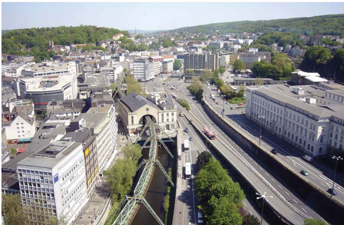
2010 soll der neue Döppersberg in Angriff genommen werden. Die ehemalige Bahndirektion (re.) ist wohl schon verkauft. Bild: thk
